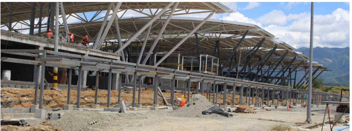
Obras Aeropuerto de Ibagué Foto: Grupo divulgación y prensa
